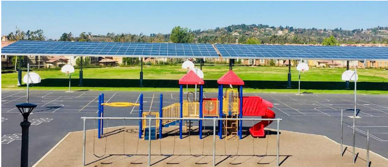
Se están construyendo estructuras de sombra solar en muchas escuelas del TUSD, incluyendo la Escuela Orchard Hills (arriba).
